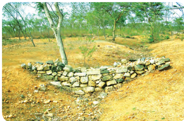
Fig. 6.9 : Gully plug
